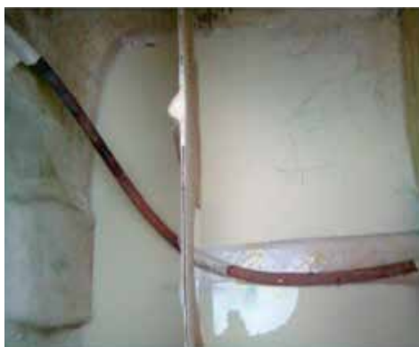
Interior del tanque con obstáculos que complican la limpieza
